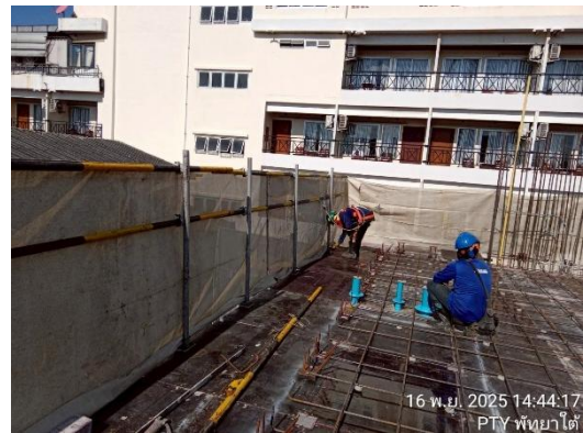
รูปที่ 55 ติดตั้งผ้ากันฝุ่น
